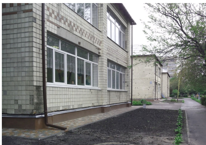
Фото 2. Дитячий садок до ремонту
