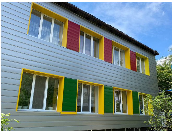
Фото 6. Система НВФ «Профіль СМАРТ-15» на фасаді дитячого садочку «Калинка», м.Бровари.
