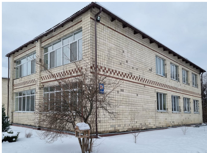
Фото 1. Дитячий садок до ремонту
